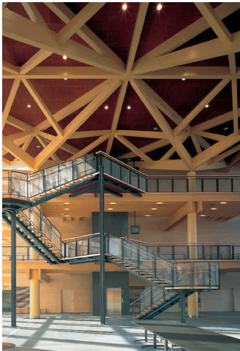
Liimapuurakenteita Lahden Sibeliustalolla.
