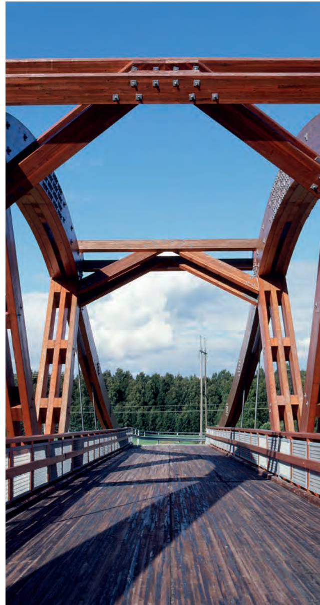
Nahkia Bridge, Toijala
