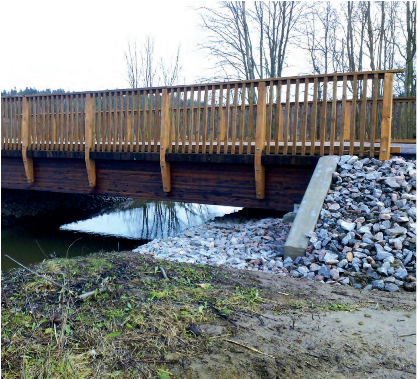
Fallängin silta, Espoo
