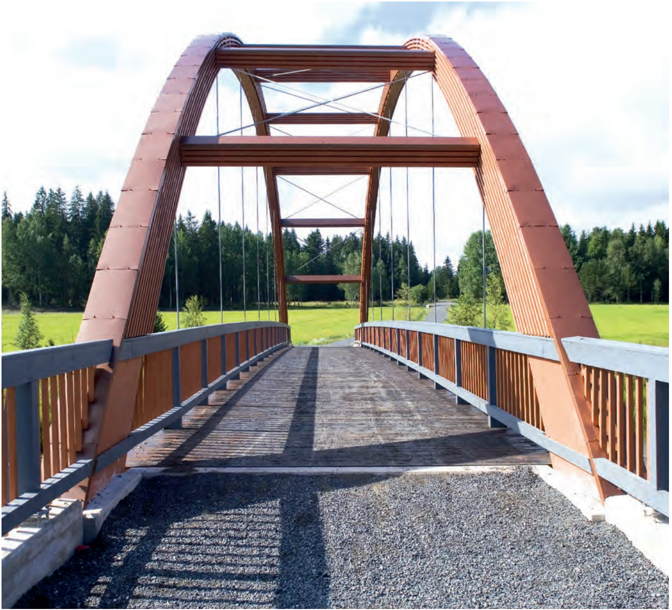
Kurjenmäen silta, Ypäjä
