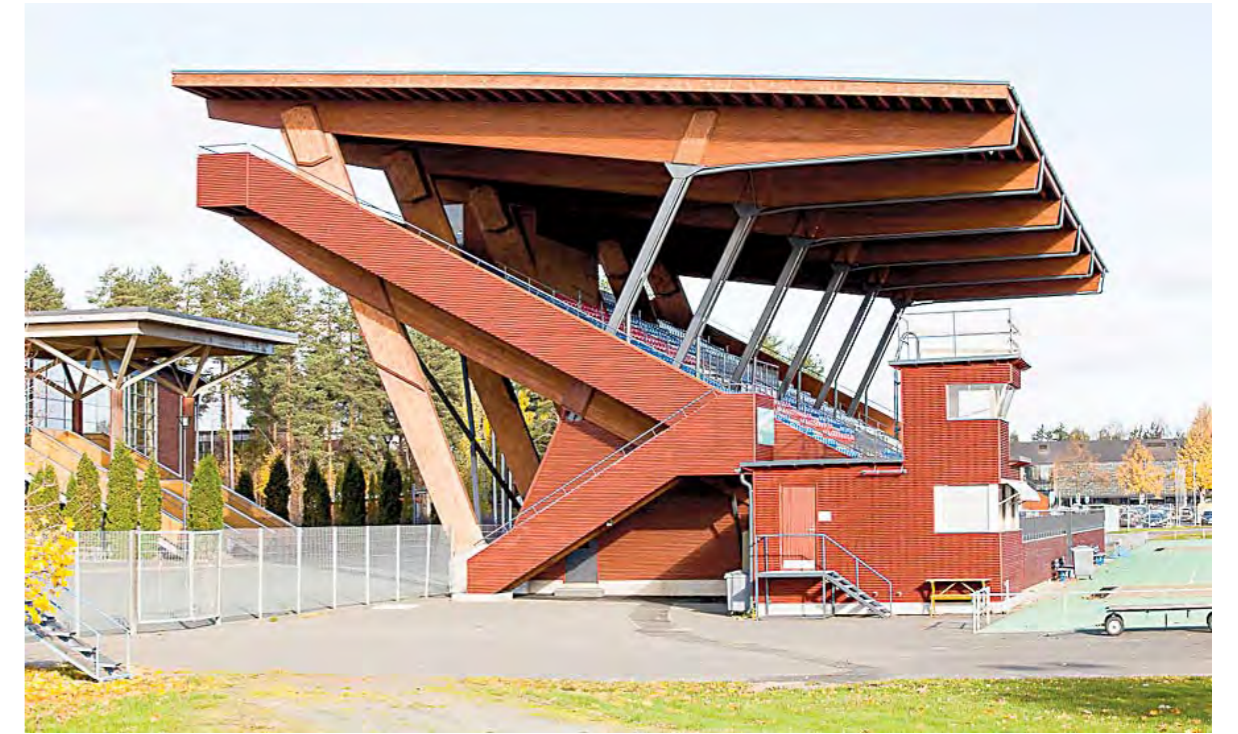
Mehtimäen katsomon rakennusmateriaalit ovat pääasiassa Versowoodin liimattuja tuotteita. Kuva: Widelens/Miska Korpela
